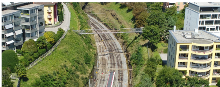
Ponte per attraversamento delle condotte
